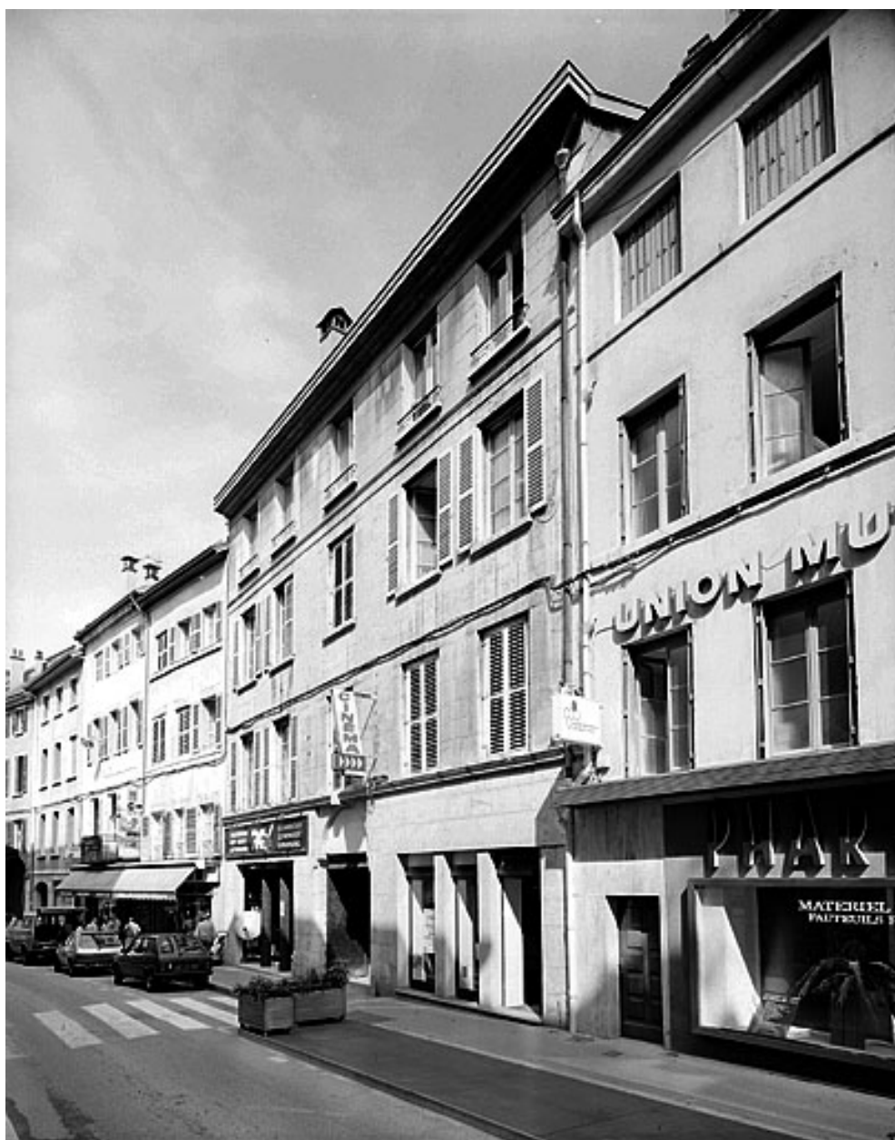
Bâtiment rue de la Poyat : façade antérieure.
