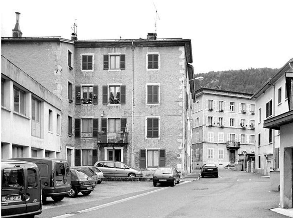
Bâtiment au n° 21, vu du nord.
