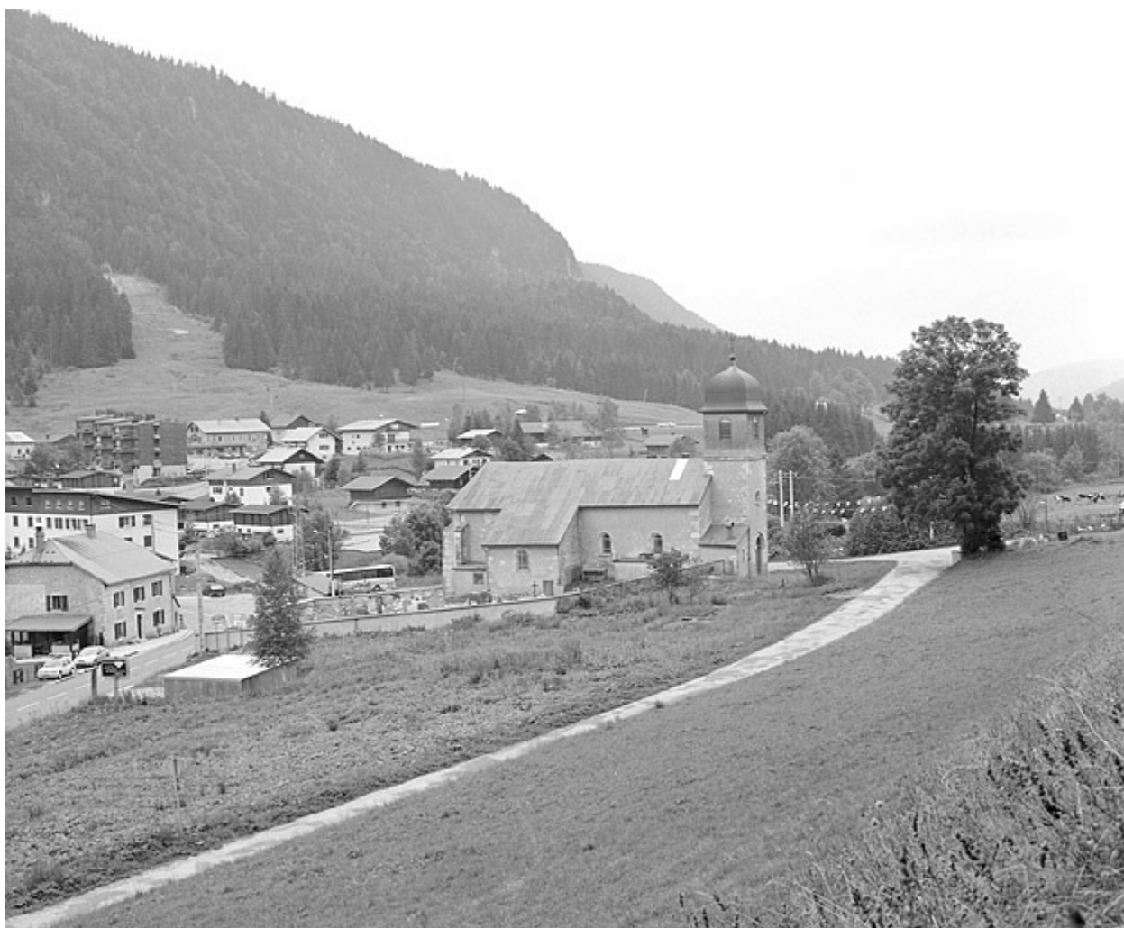
Vue de situation depuis le nord.
