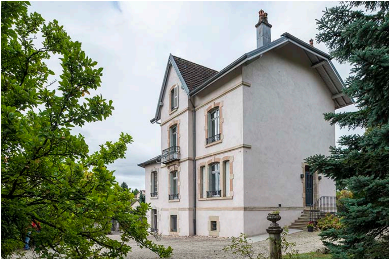
Le mur pignon nord.
