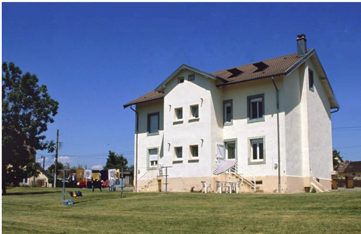
Façade postérieure d'un logement ouvrier.
