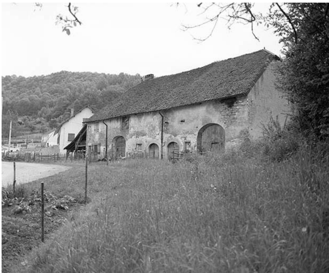
Ferme située rue Saint-Vincent.
