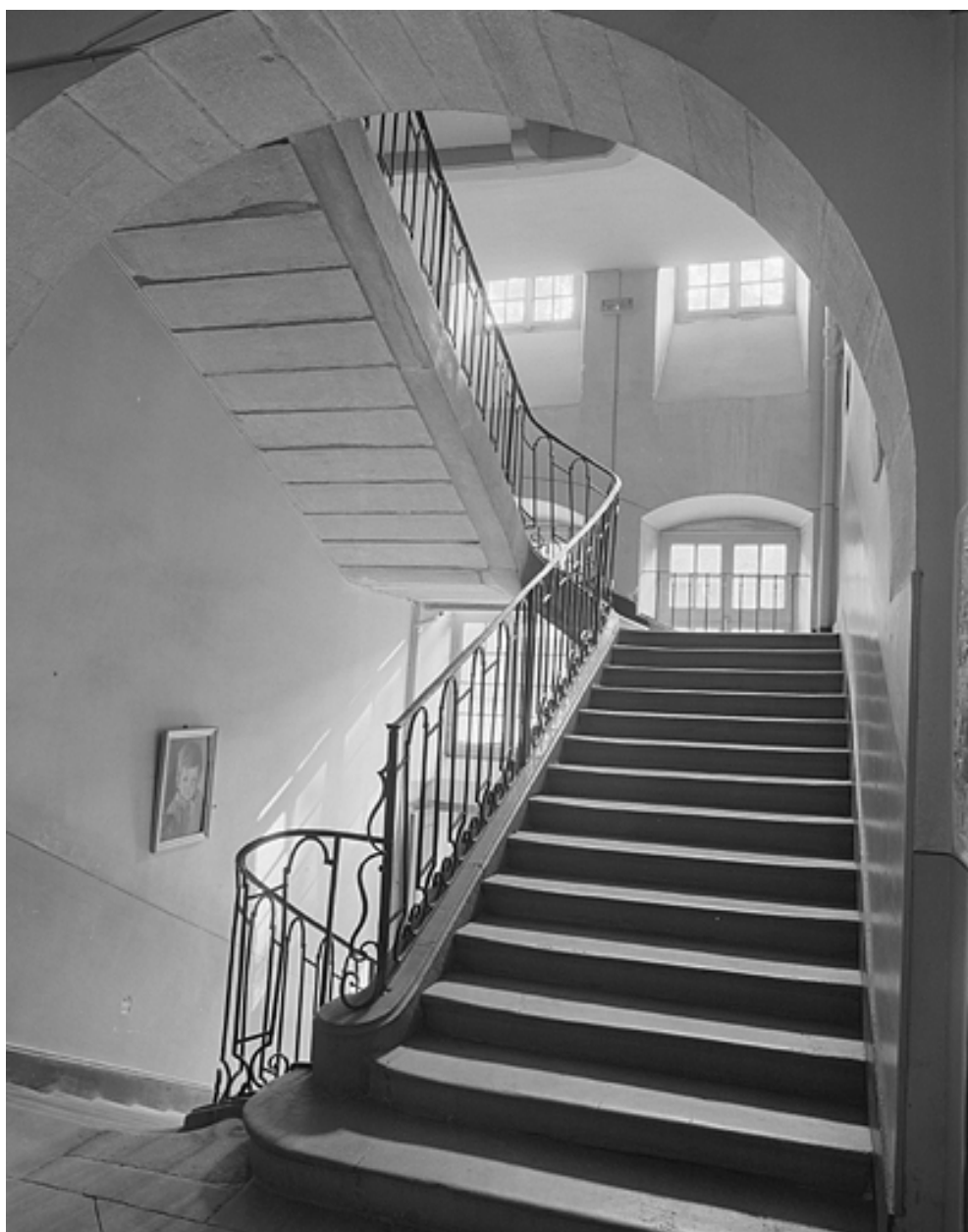
Bâtiment principal, escalier.
