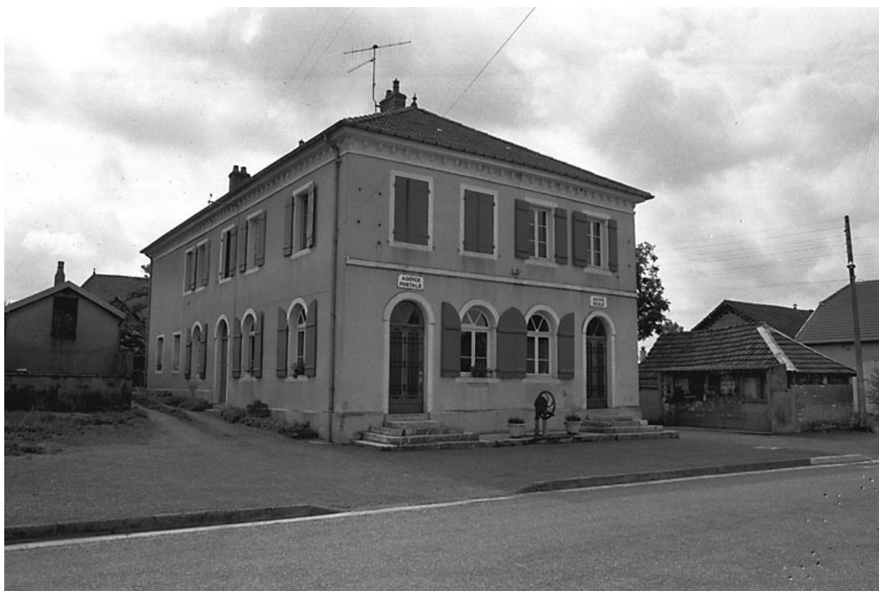
Façades antérieure et latérale gauche.
