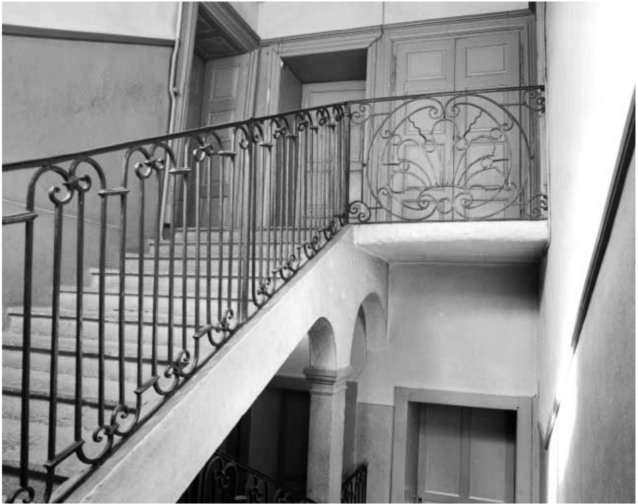
Intérieur : vue générale de l'escalier.
