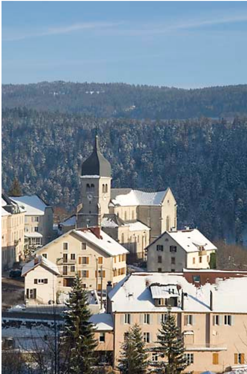
Vue générale depuis le Mont Ramey en 2008, en hiver.
