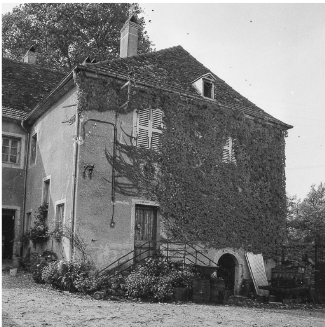
Ferme située rue des Enclos.
