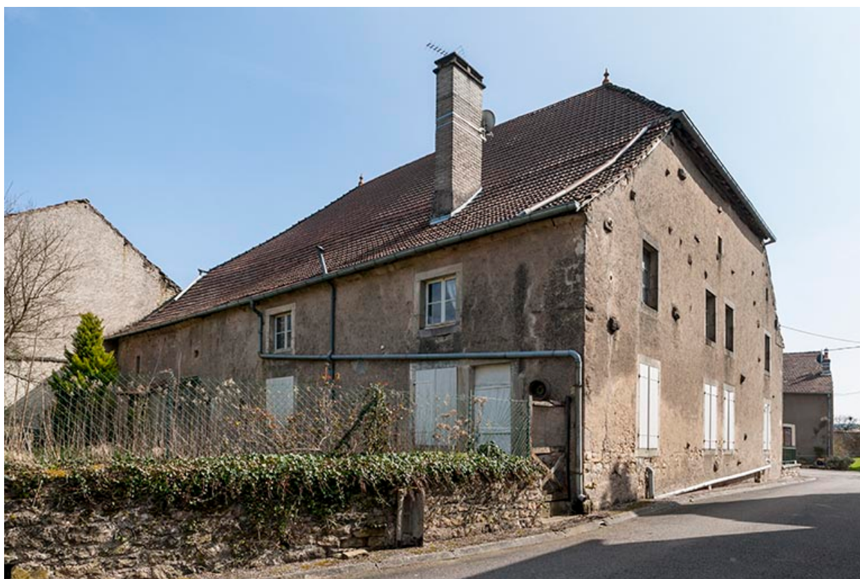
Façade postérieure et mur pignon ouest.
