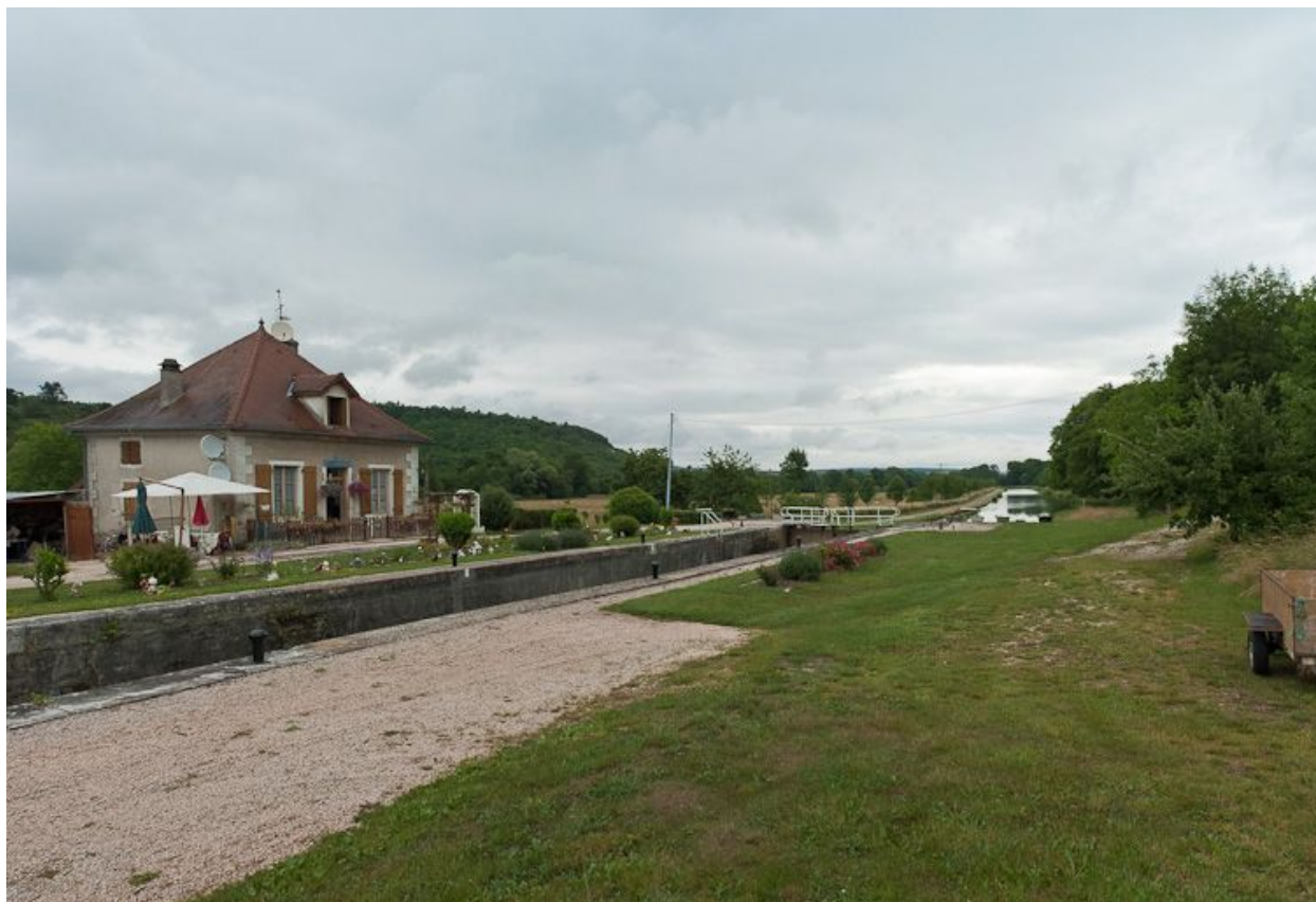
Vue d'ensemble du site d'écluse.
