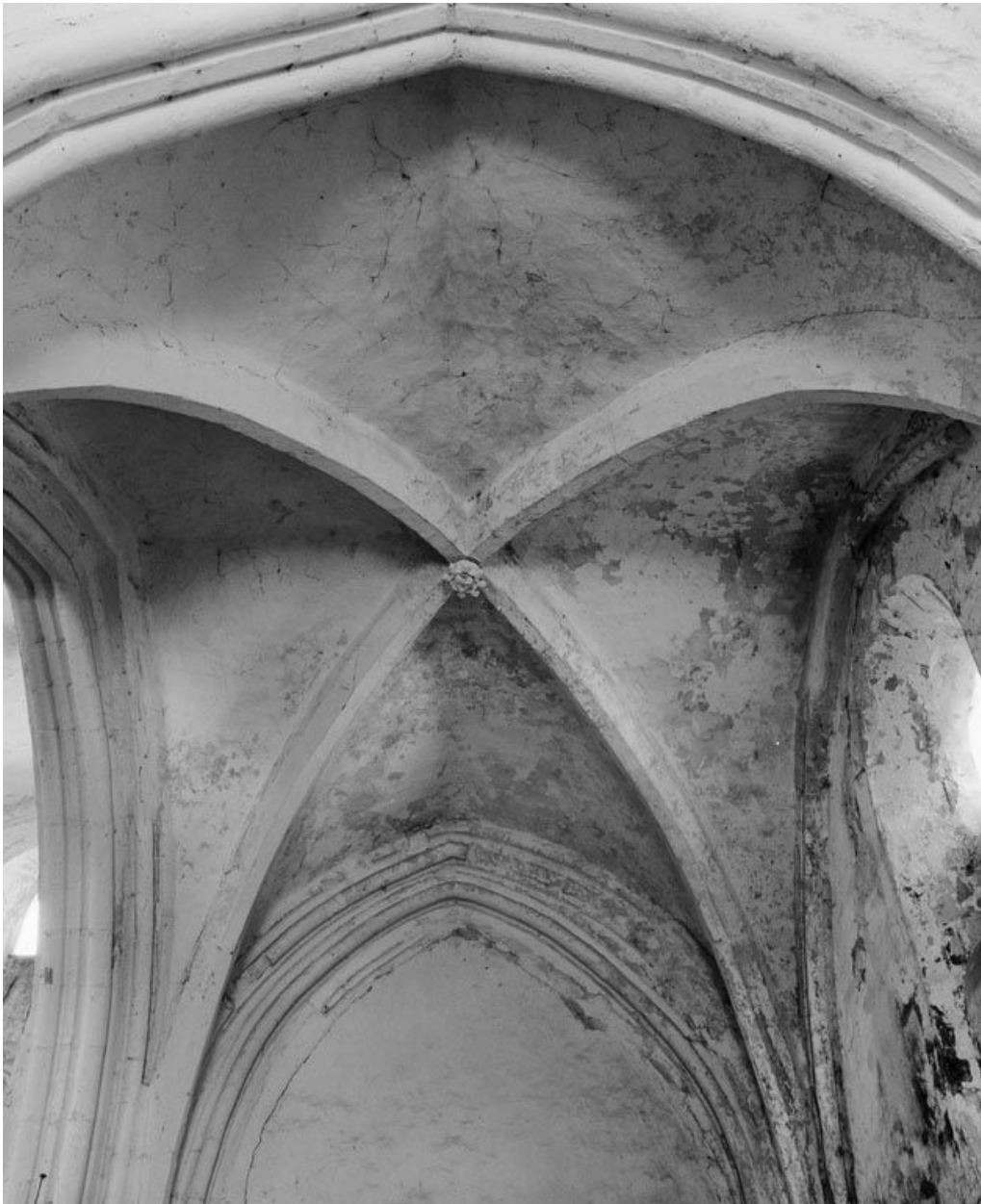
Collatéral gauche, 2 e travée : voûtement.
