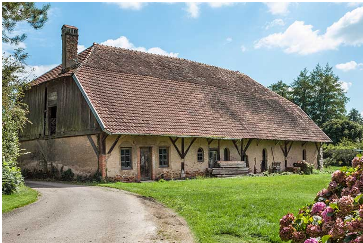
Magasin industriel depuis le nord-ouest.
