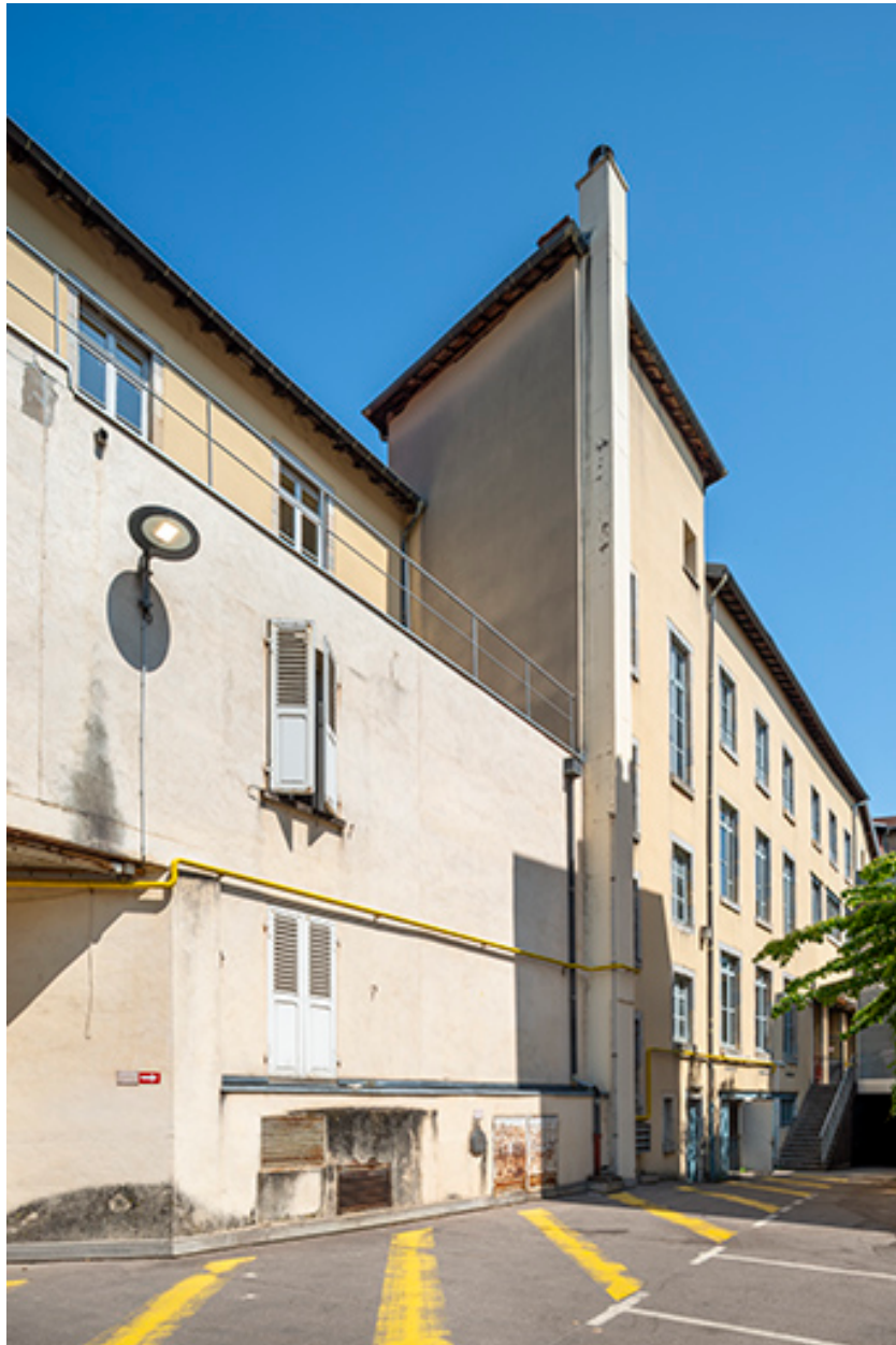
Ancienne brasserie (bâtiment Proudhon) : façade postérieure, vue en enfilade.
