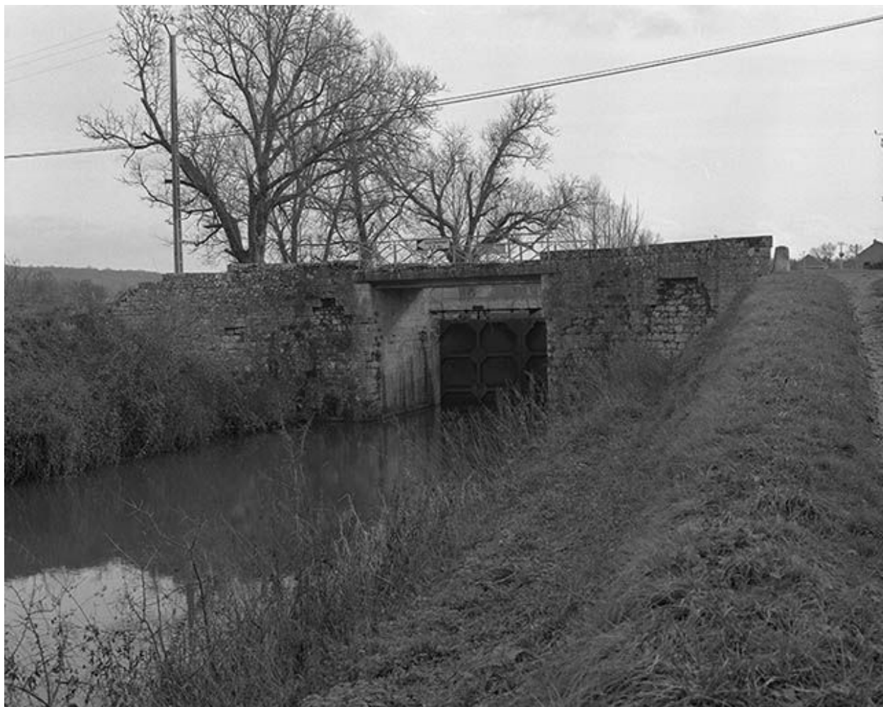
L'écluse et le pont.
