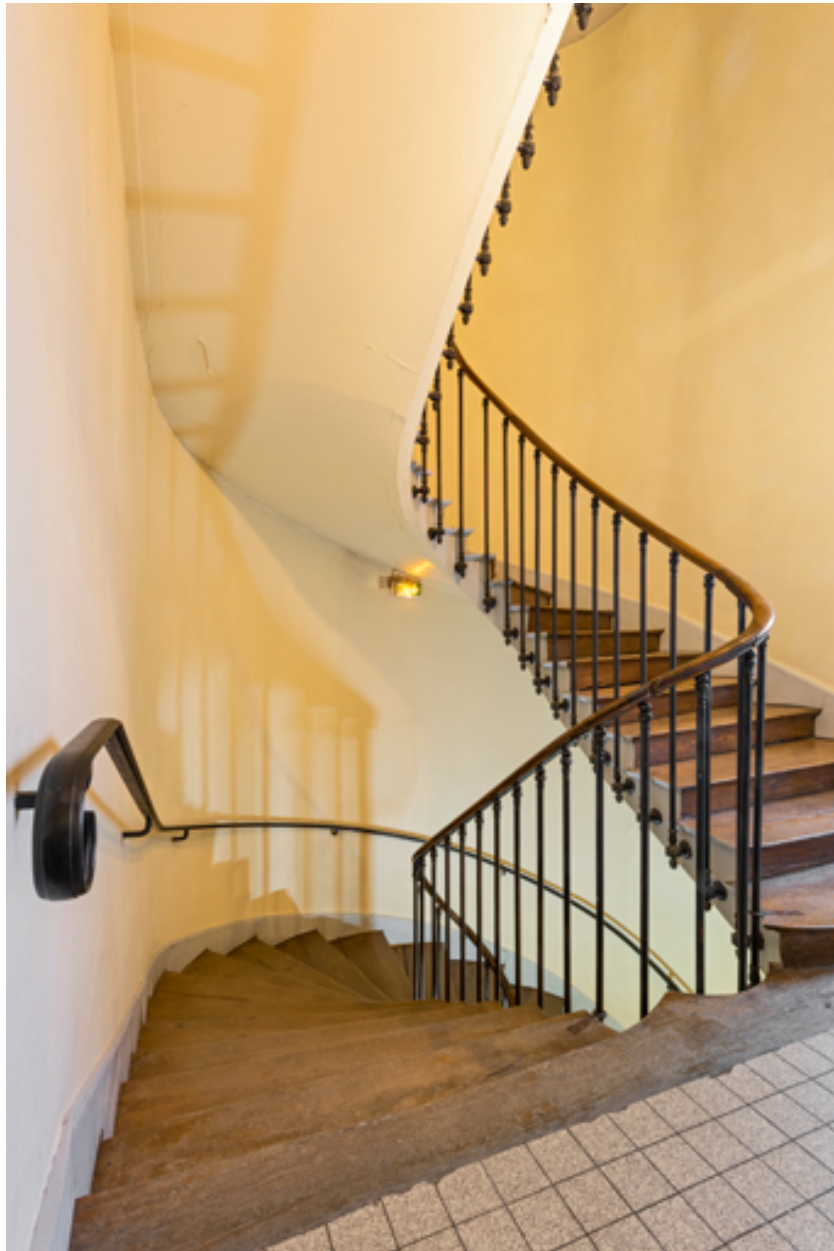
Escalier, au palier de l'étage carré.
