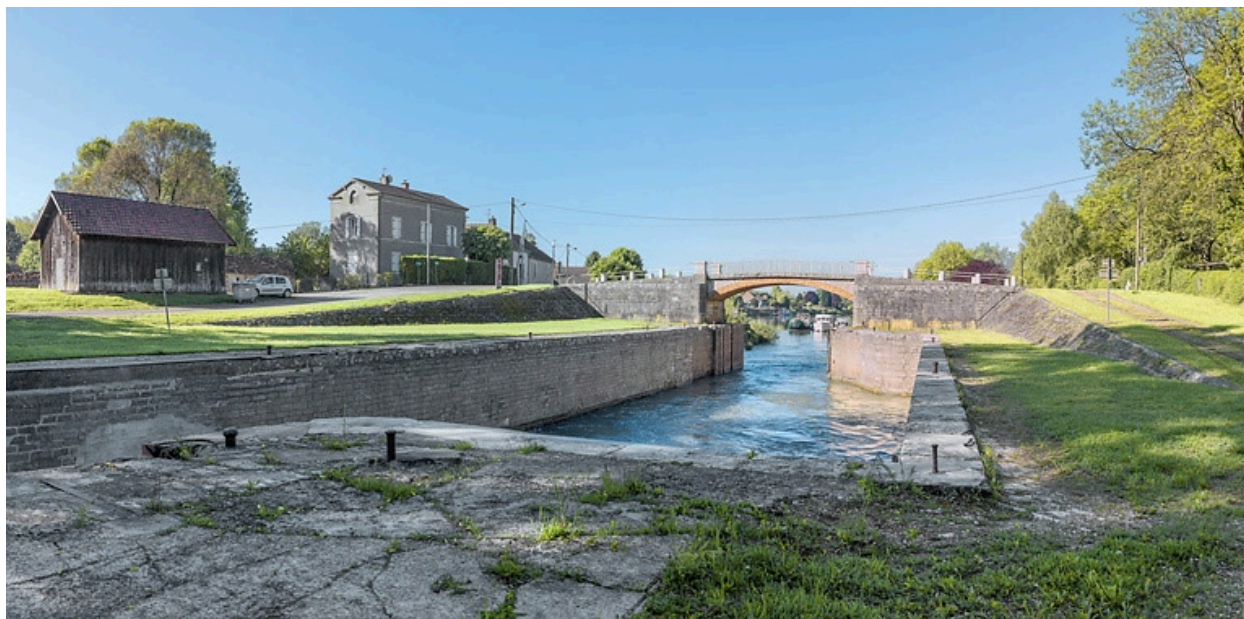
Le site d'écluse du Châtelet et sa maison éclusière à étage (21).
