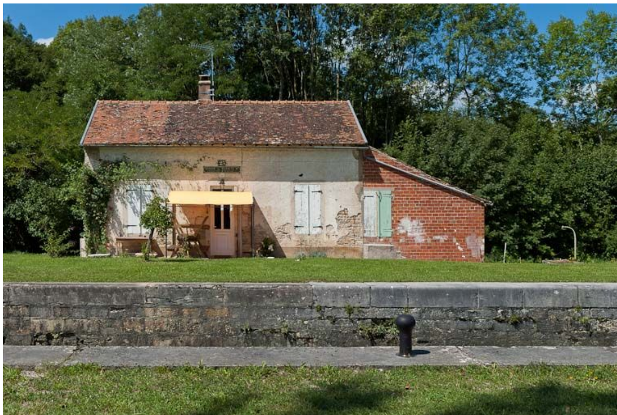
Vue de face de la maison éclusière.
