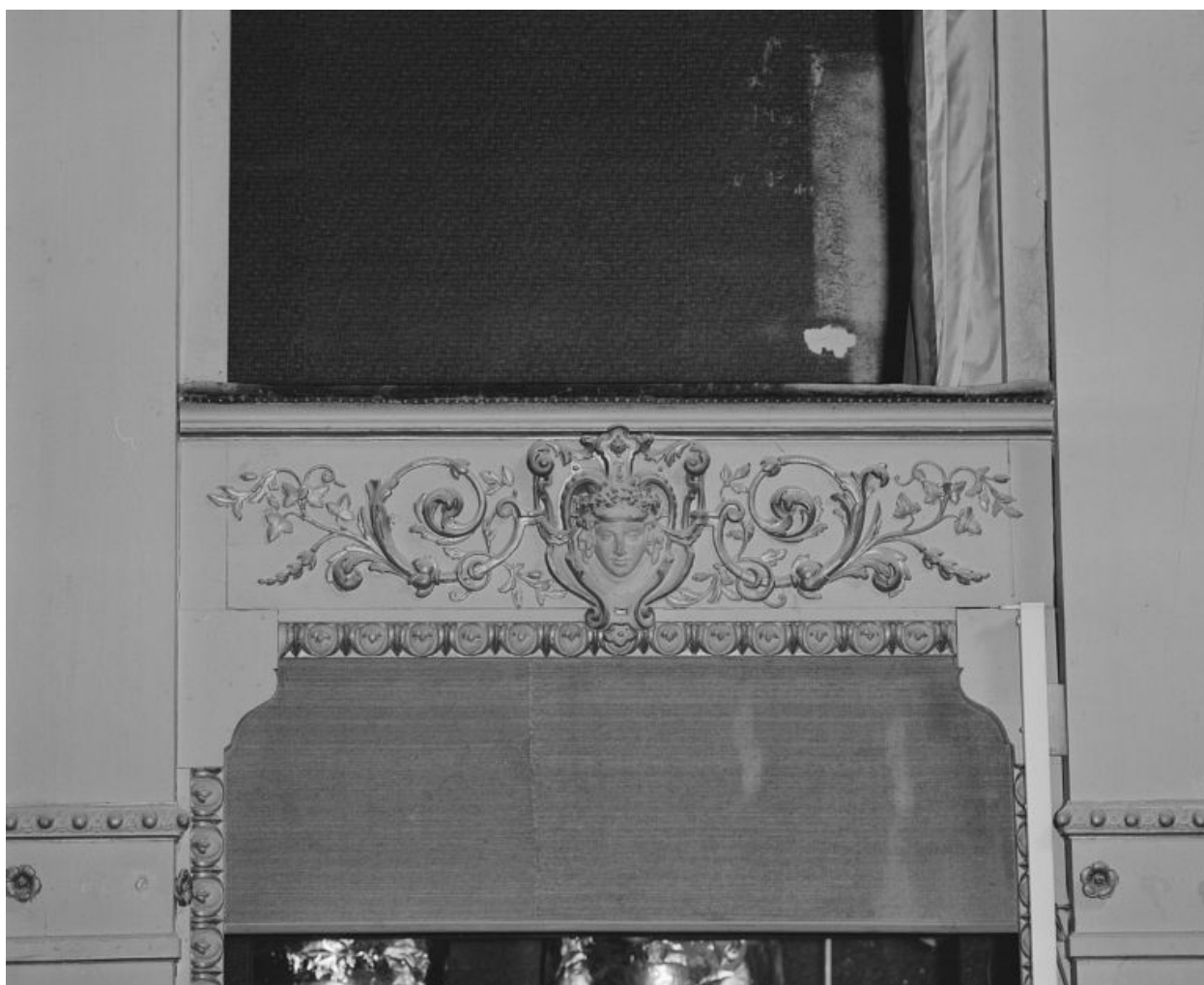
Salle : garde-corps de la 2e loge d'avant-scène, côté cour, en 1988, avant restauration.
