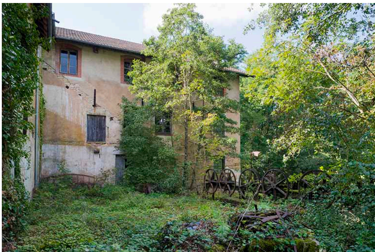
Façade postérieure de l'atelier de fabrication.
