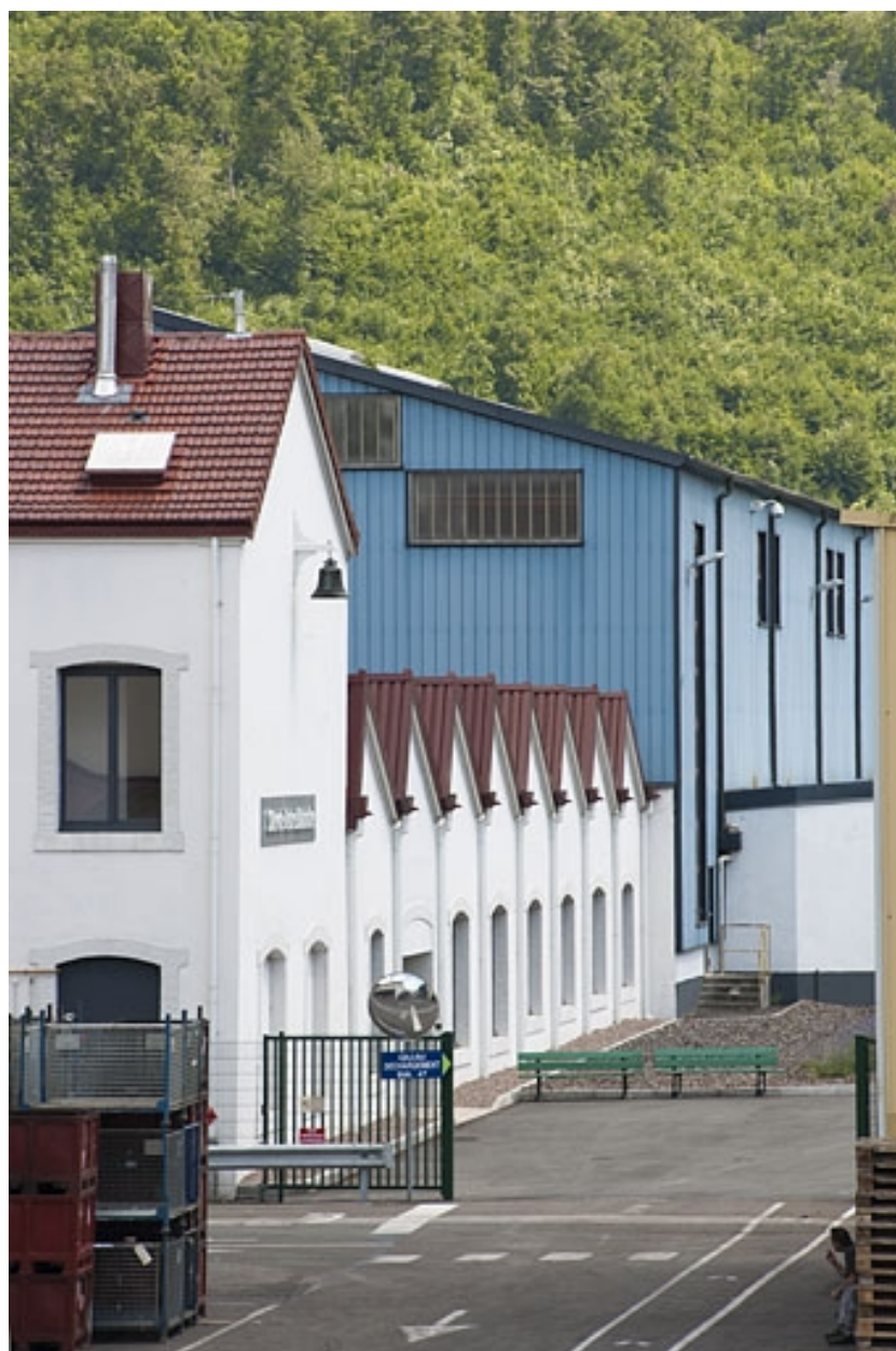
Vue en enfilade des bâtiments sud.
