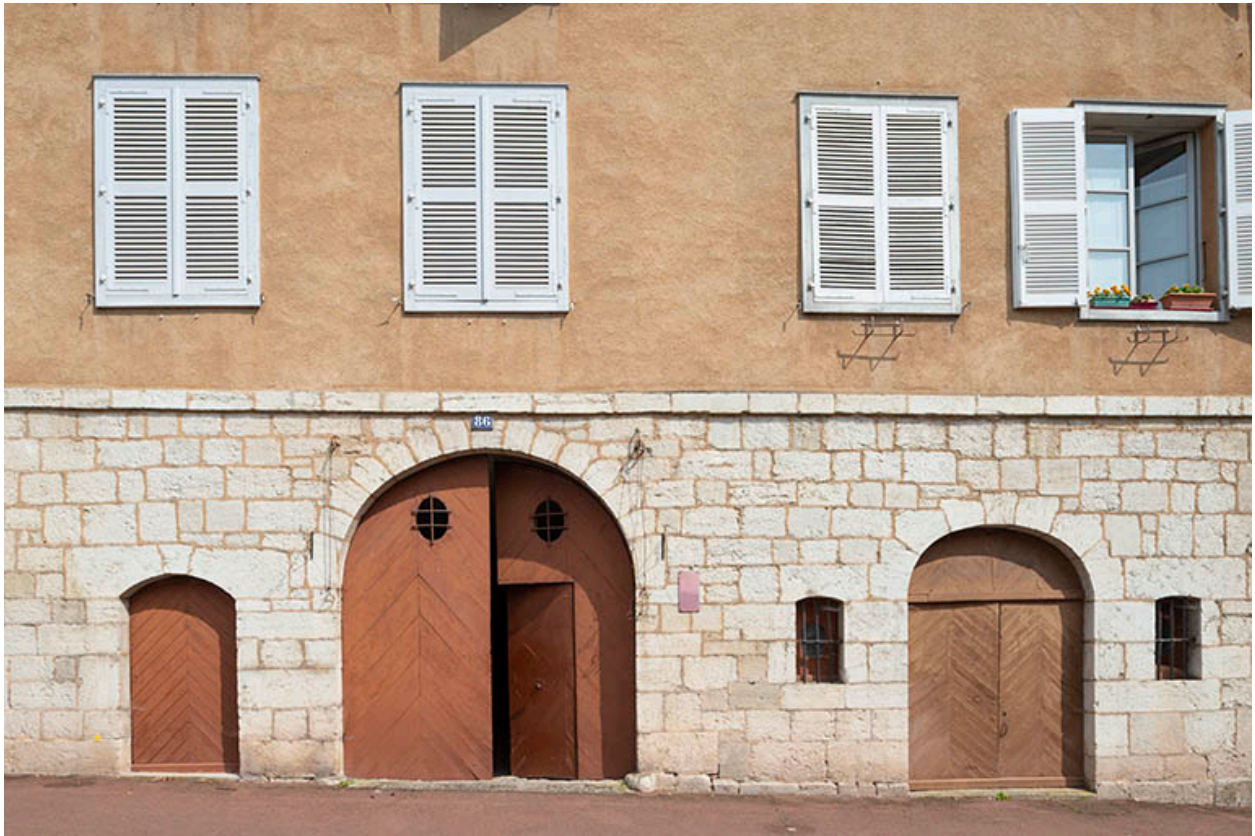
Les premiers niveaux de la façade antérieure.
