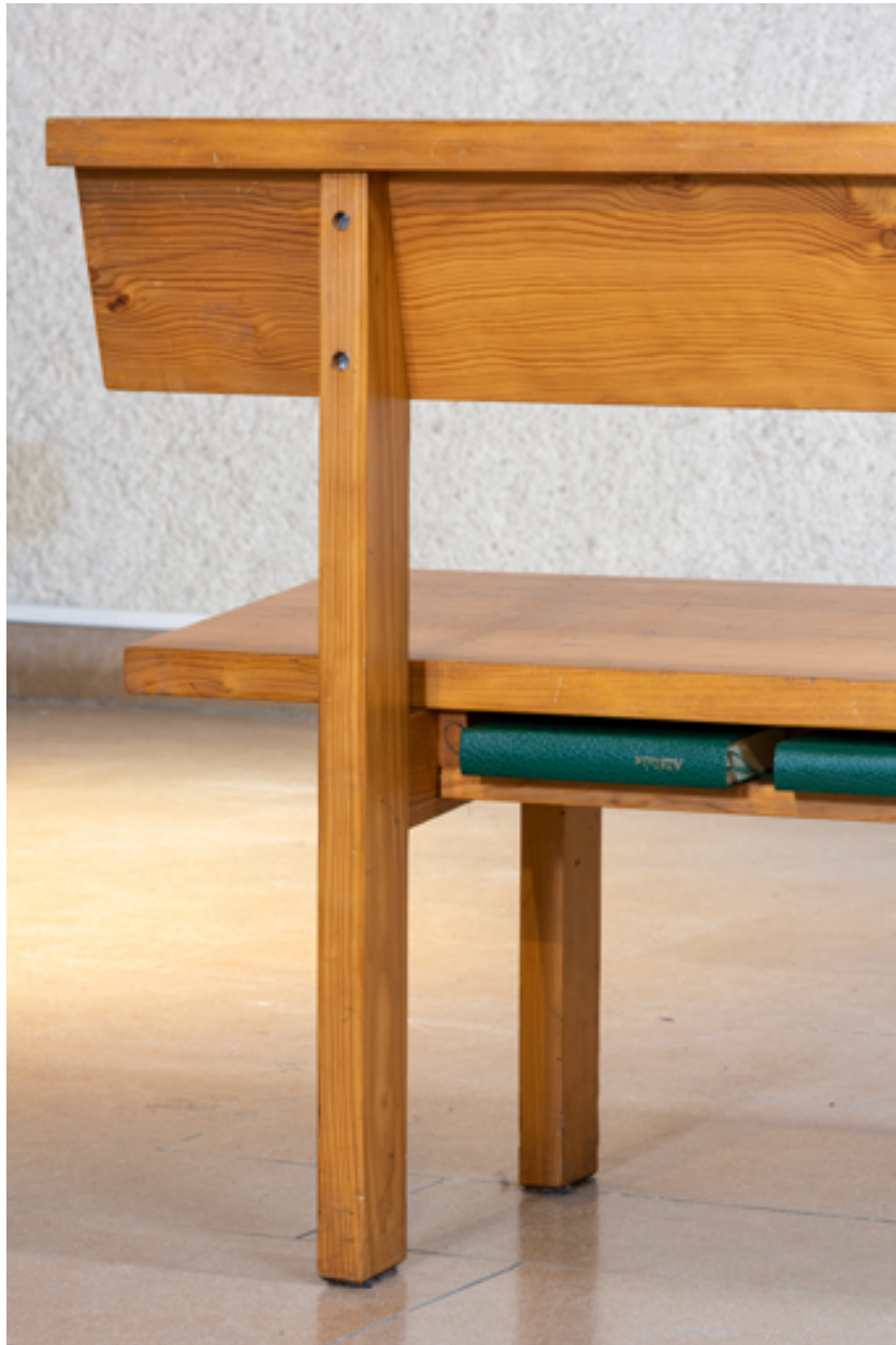
Détail du casier pour les livres de cantiques, placés sous l'assise du banc.
