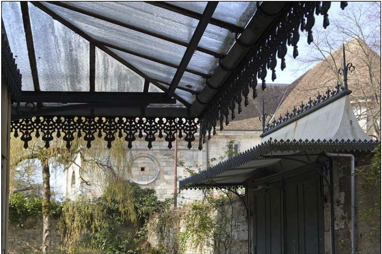
Détail du toit en tôle du portail dans clôture, depuis la porte du logis principal.
