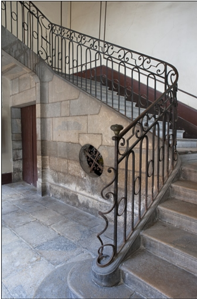
Détail du départ de l'escalier principal.
