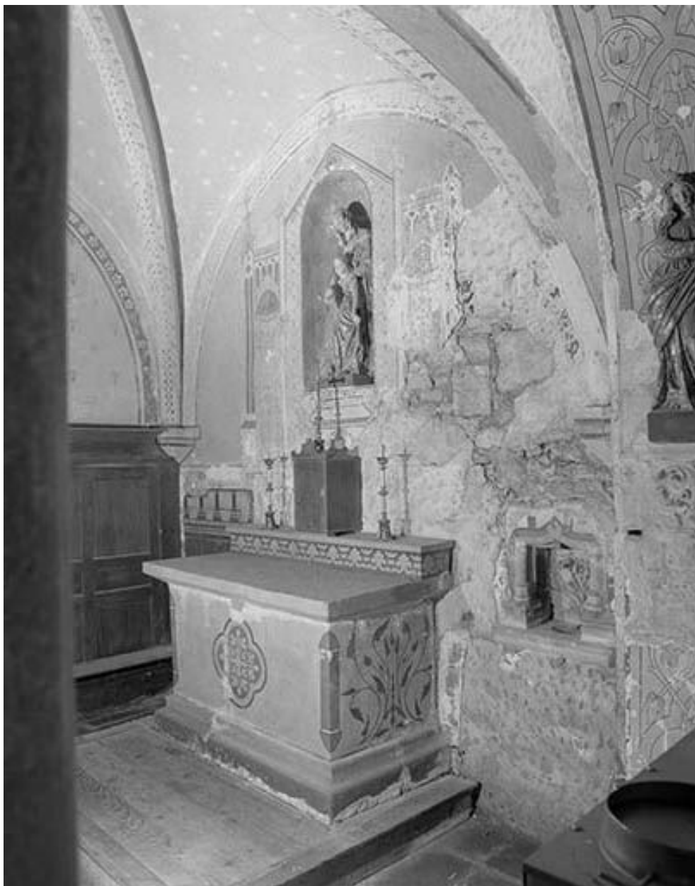
Intérieur : deuxième chapelle gauche, mur postérieur.
