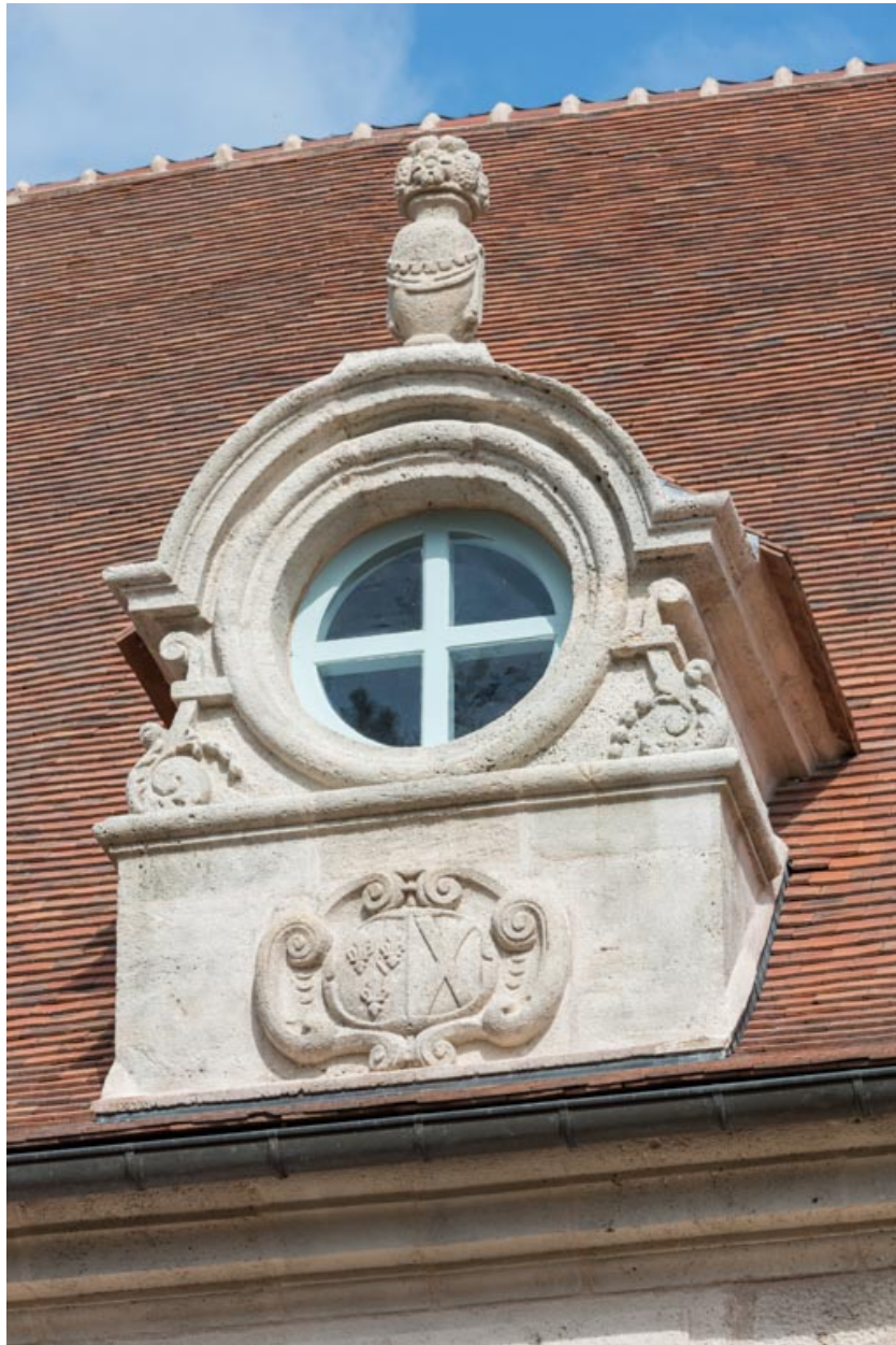
Façade sud-est, œil-de-boeuf à ailerons à volutes et à archivolte surmontée d'un pot-à-feu.
