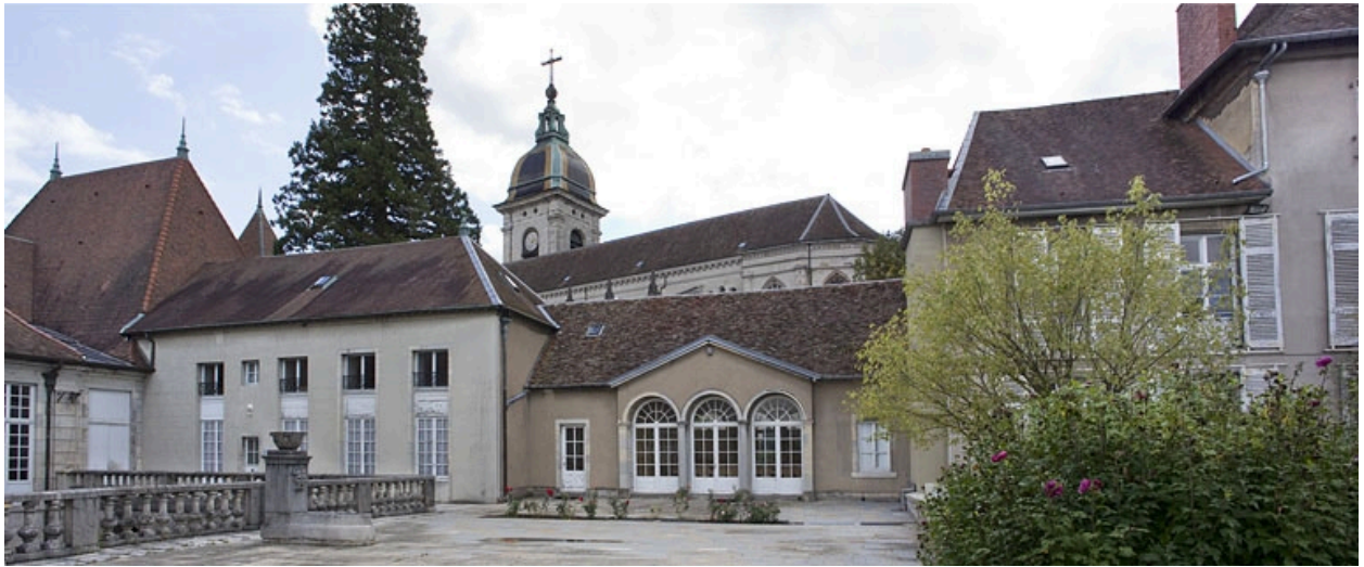
Orangerie : vue d'ensemble éloignée, de face.
