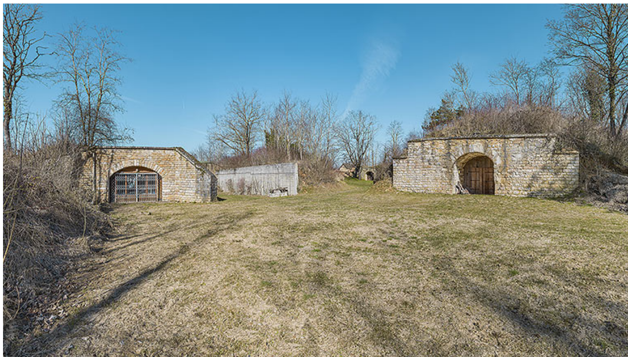
Batterie annexe du fort d'Asnières, située sur la commune de Norges.
