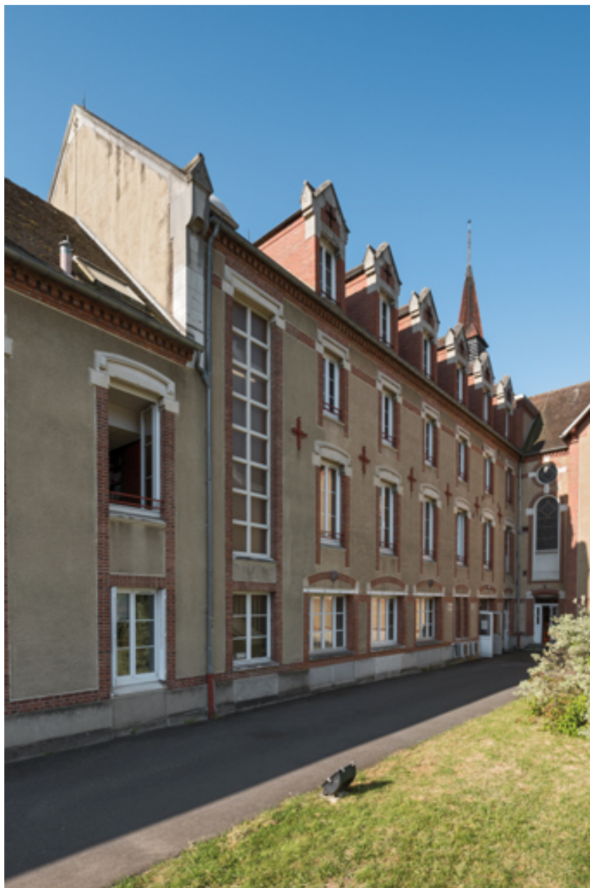
Vue de la façade nord de l'aile est
