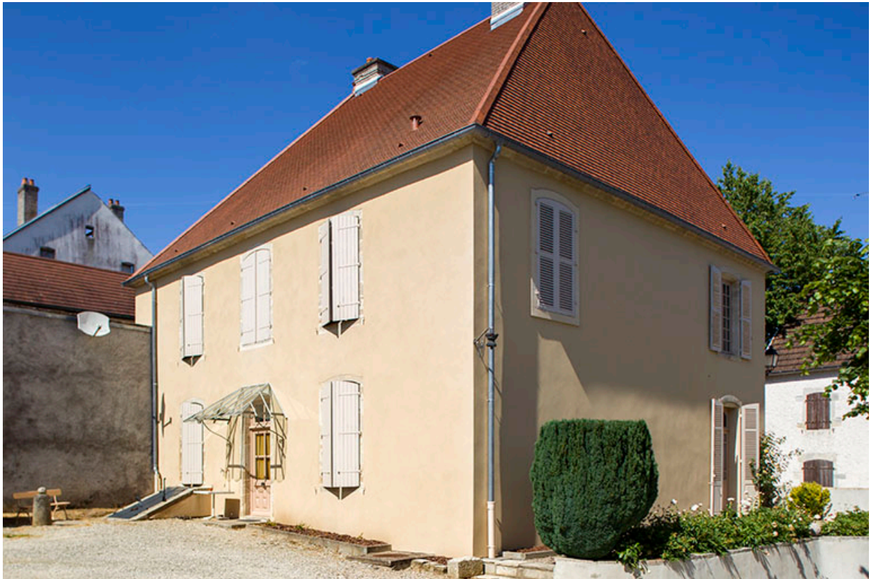
Façade postérieure de trois quart gauche.
