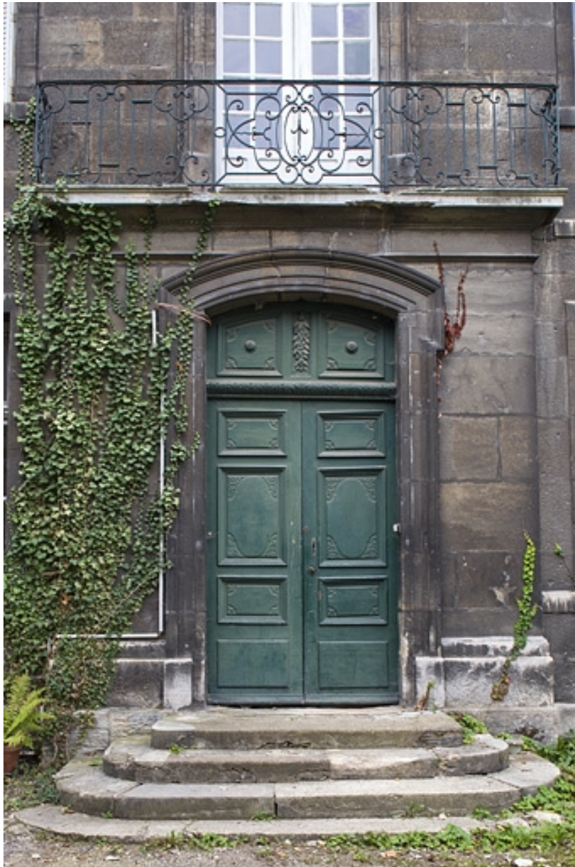
Logis principal, façade sur cour : détail de la porte d'entrée.
