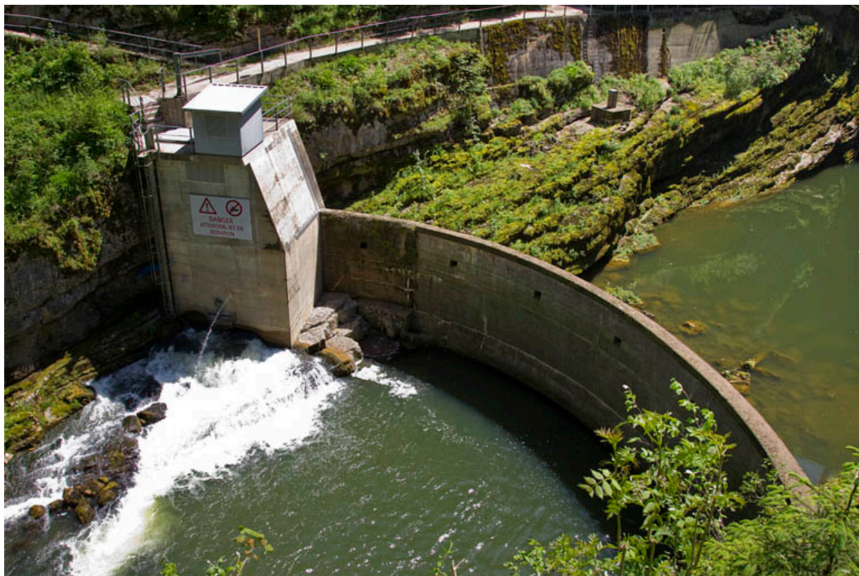
Barrage du Châtelot : barrage aval du bassin d'amortissement.
