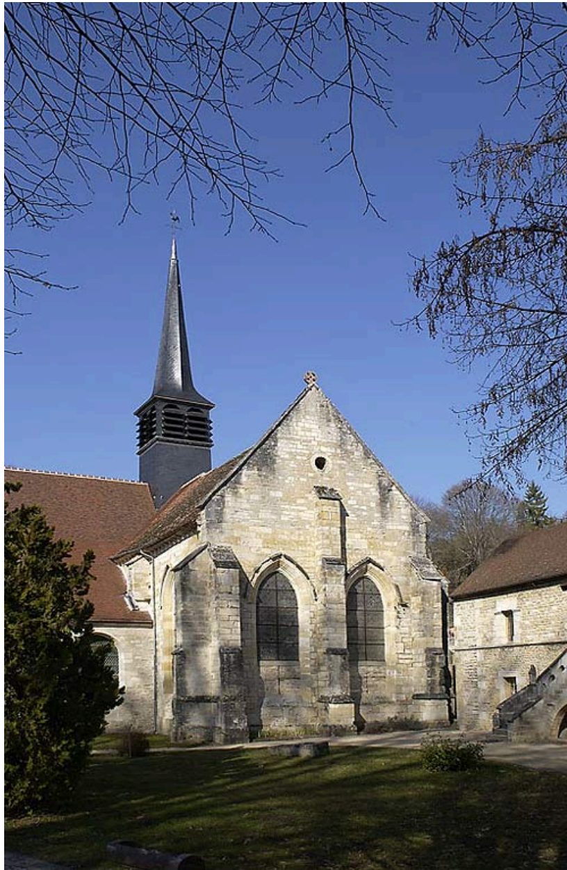
Ancienne église abbatiale, devenue paroissiale : chevet.
