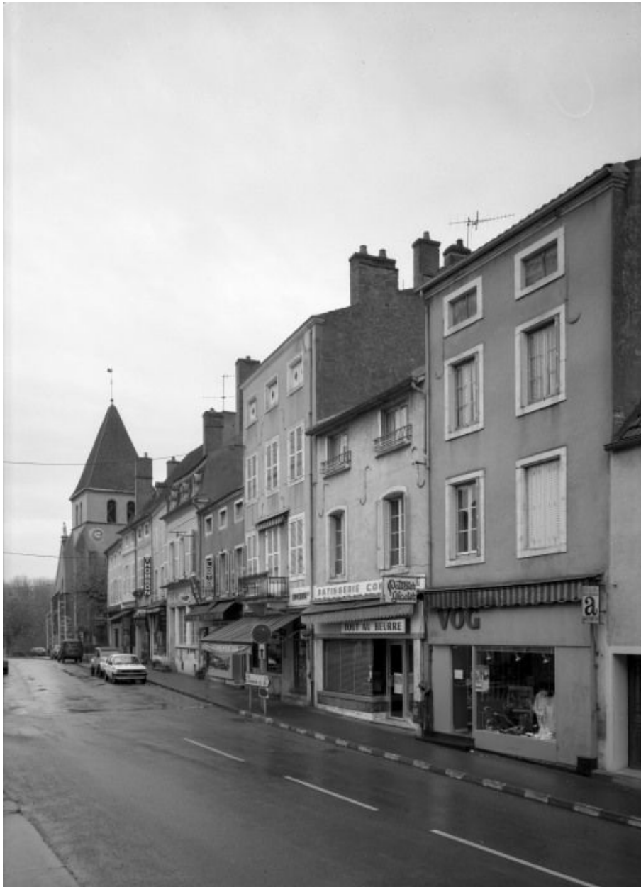
Alignement de 9 maisons (Cada. 1977, sect. AD, parc. 190 à 199 ; rue de La République).
