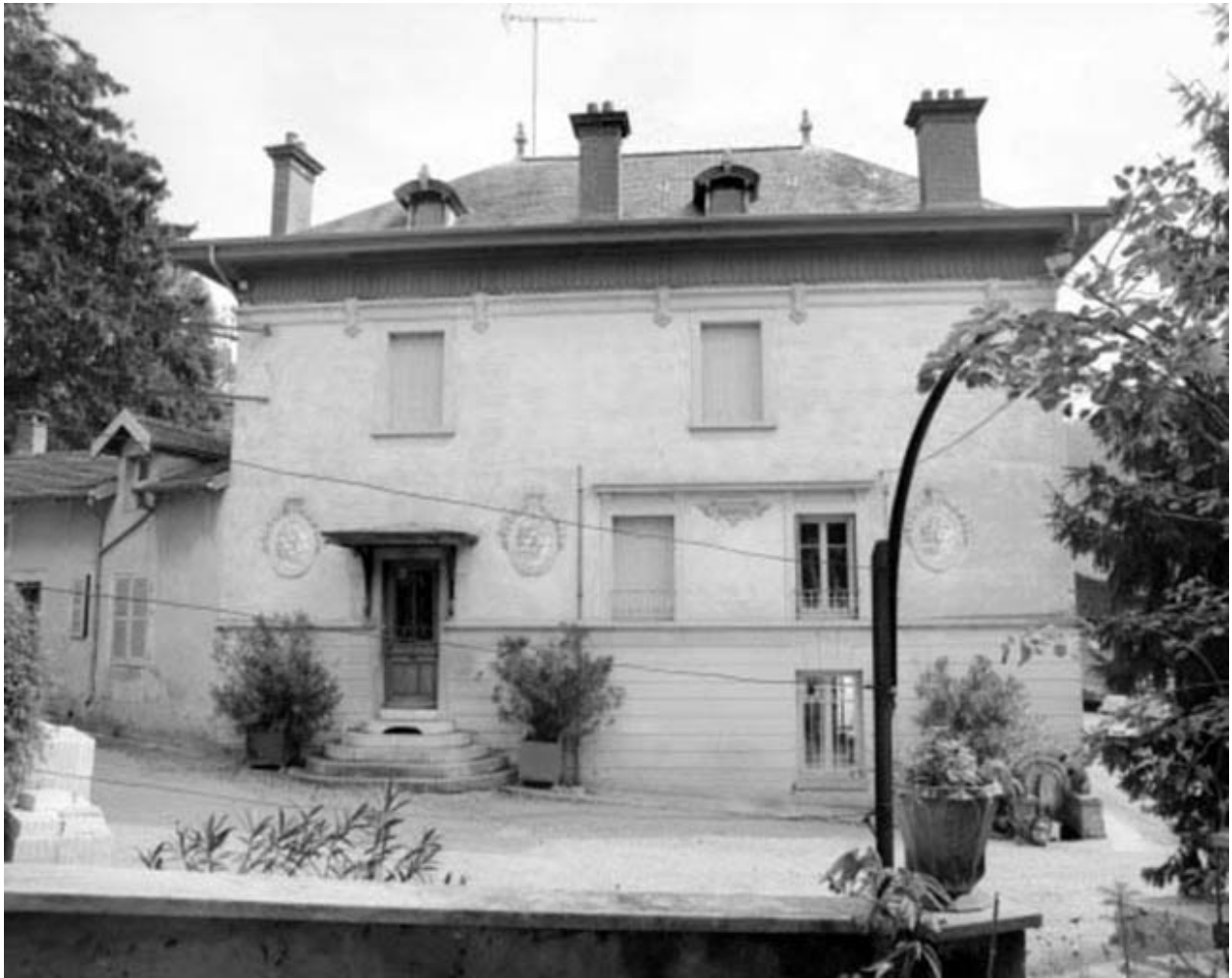
Façade latérale gauche du bureau.
