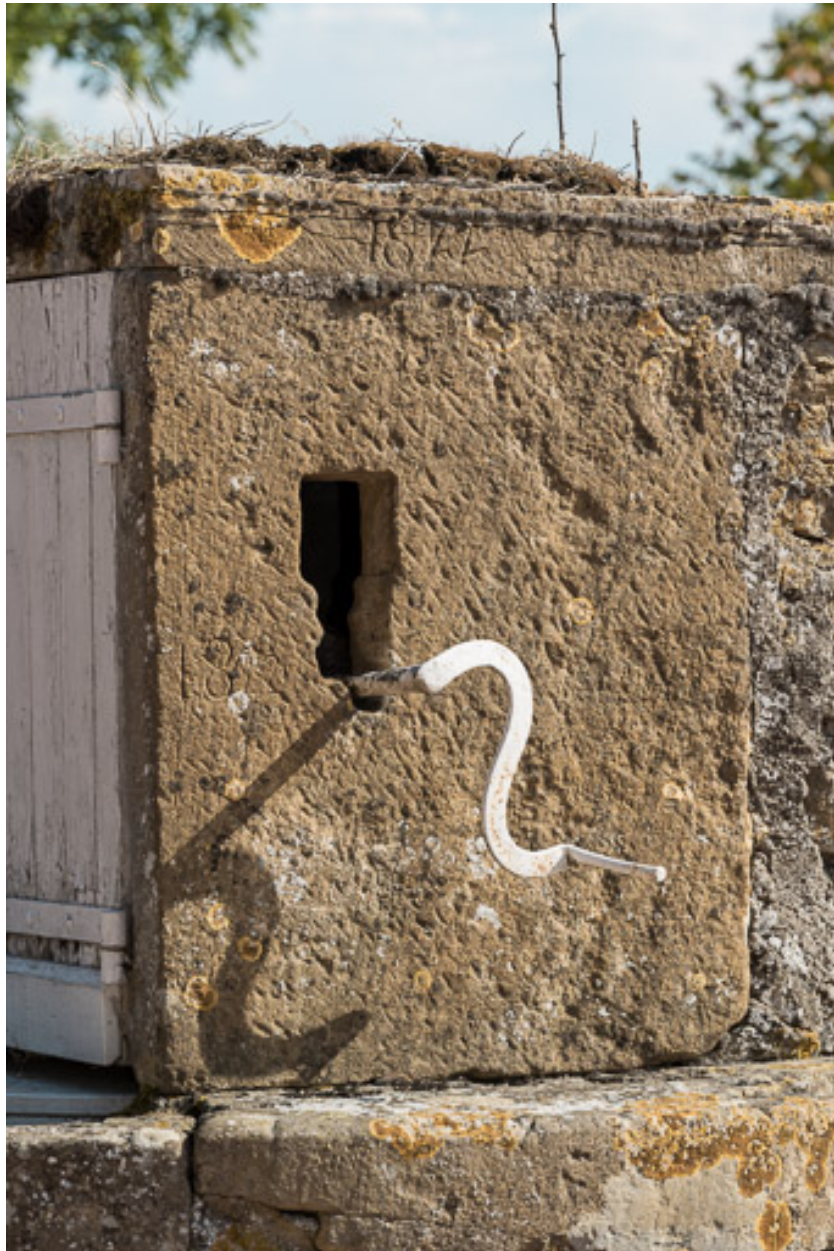
Détail du puits : superstructure avec la date "1822" gravée en partie haute
