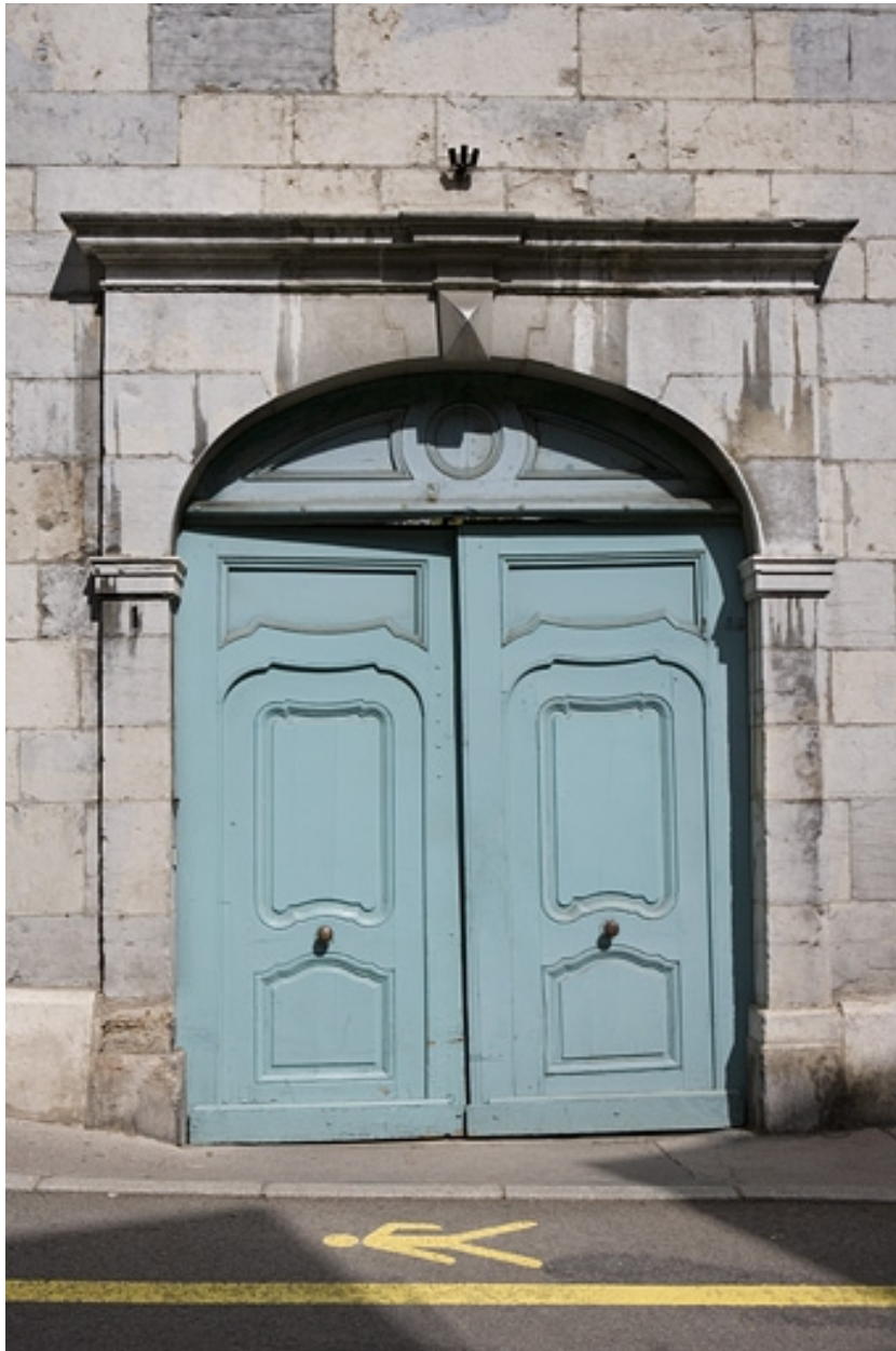
Détail du portail d'entrée sur rue.
