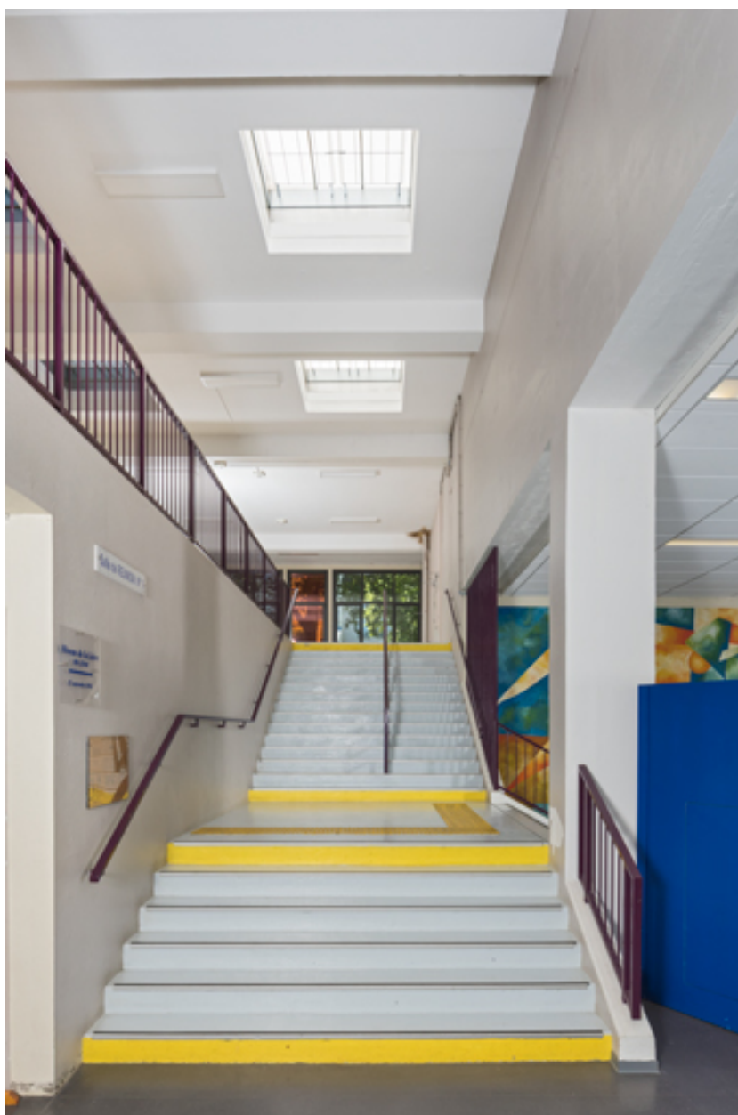
Maison des sports : escalier donnant accès à l'étage.
