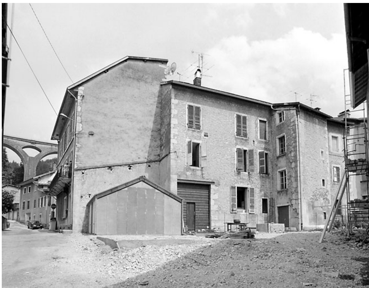
Elévation postérieure, de trois quarts gauche.
