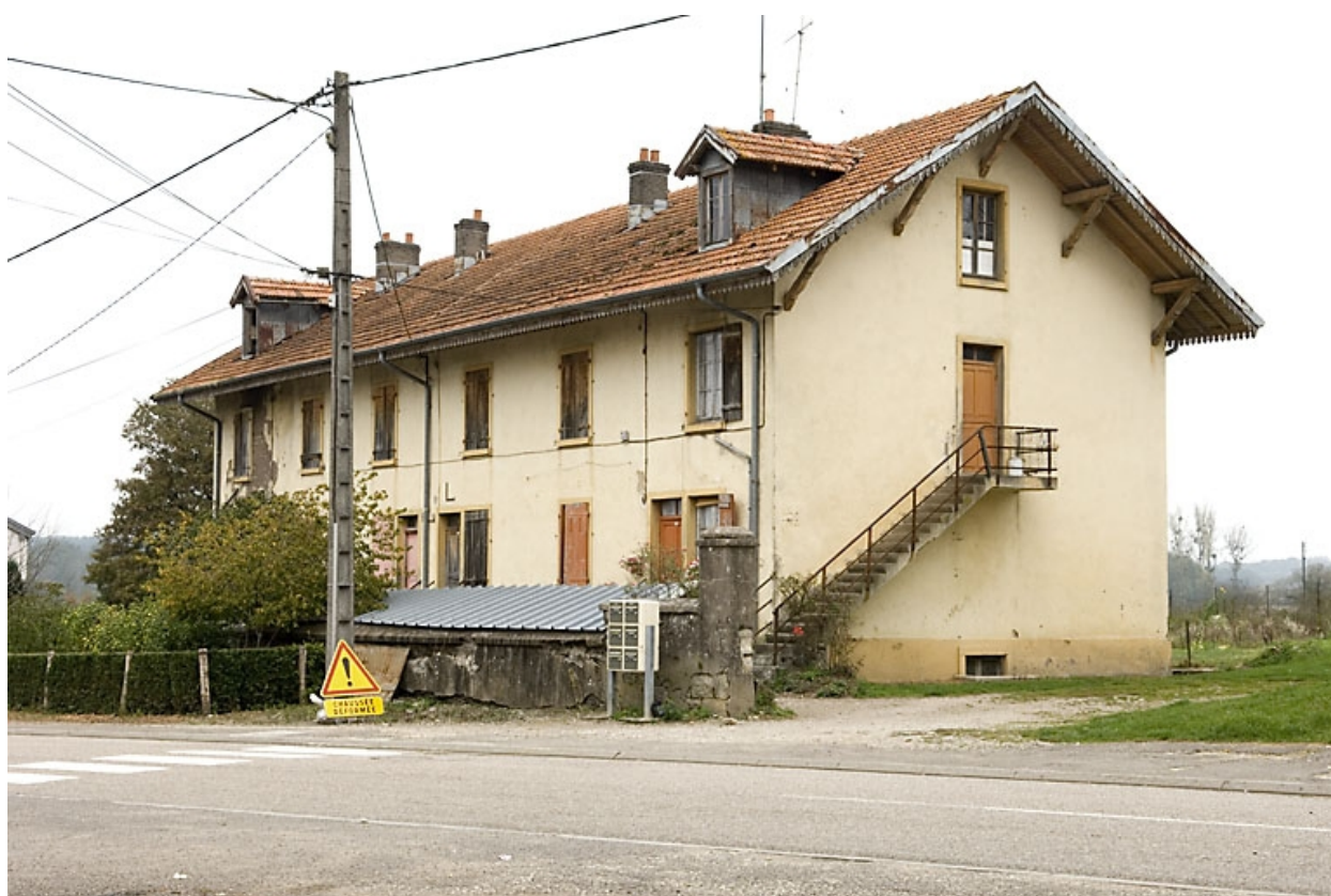
Logements d'ouvriers, bâtiment L, 4 rue du Coney.
