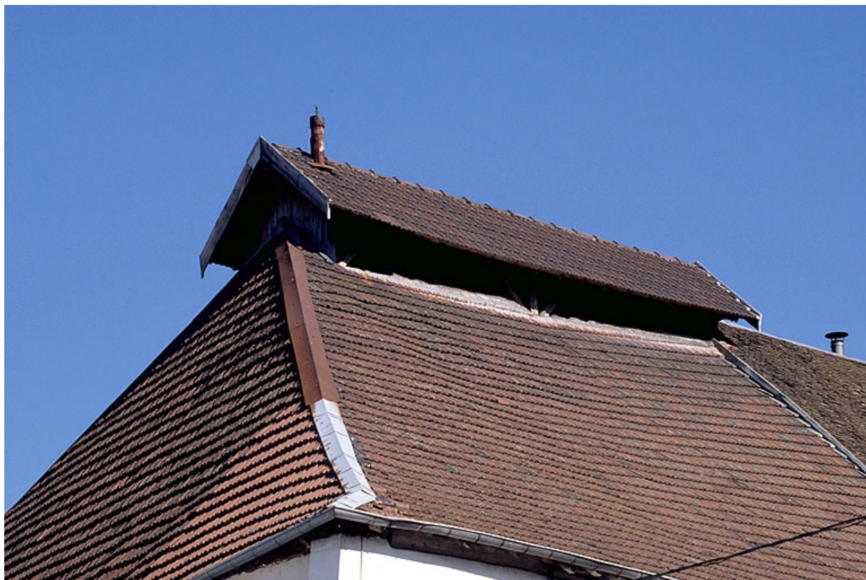
Atelier de fabrication : détail de la toiture.
