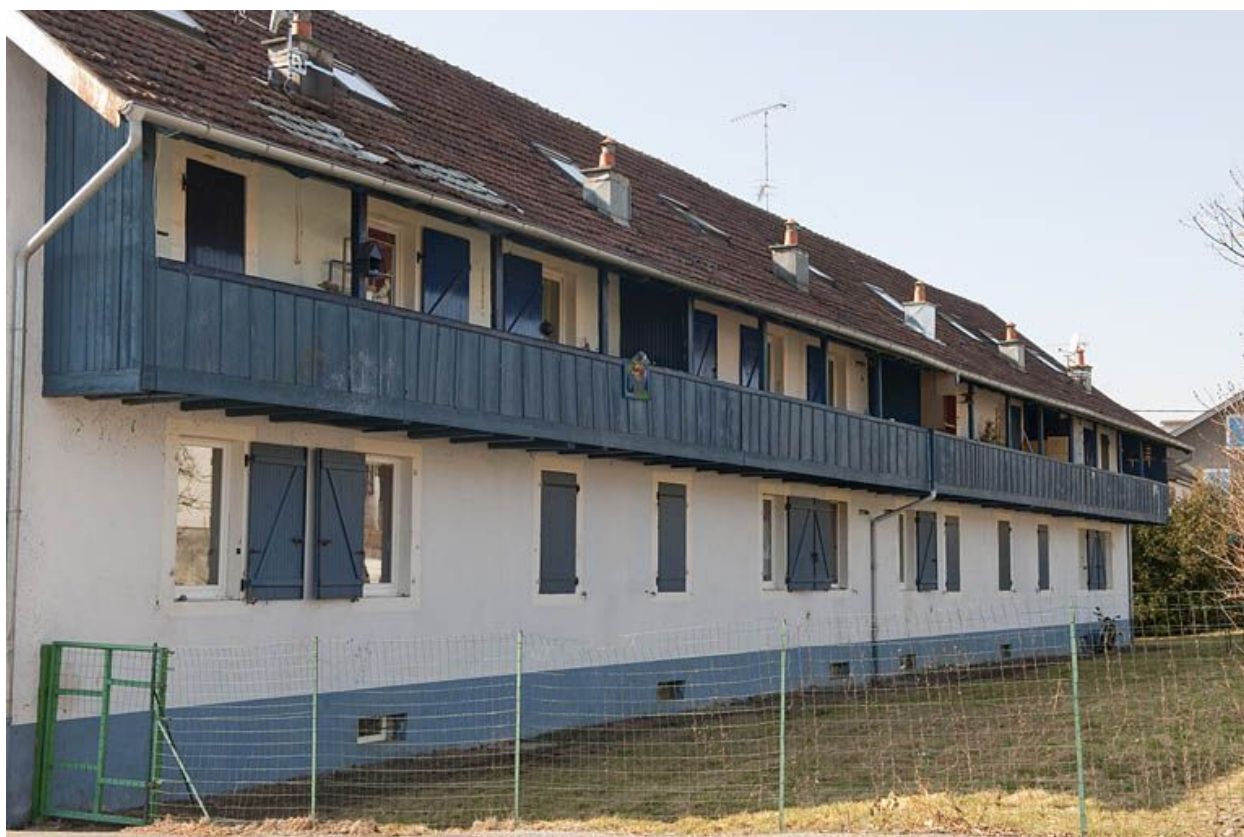
Immeuble de 12 logements. Façade postérieure.
