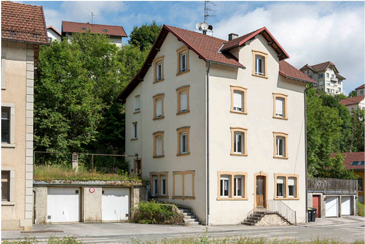
Maison (vers 1900) et atelier d'horlogerie François Anguenot, puis Marcelin Joriot, puis Roger Maret, au 9 rue du Lac. Fabrique de montres.
