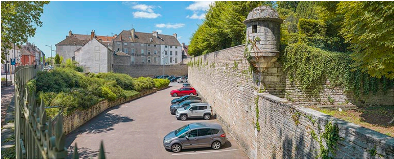
Vue d'une face du bastion.
