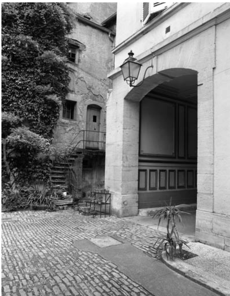
Le passage couvert, côté cour.
