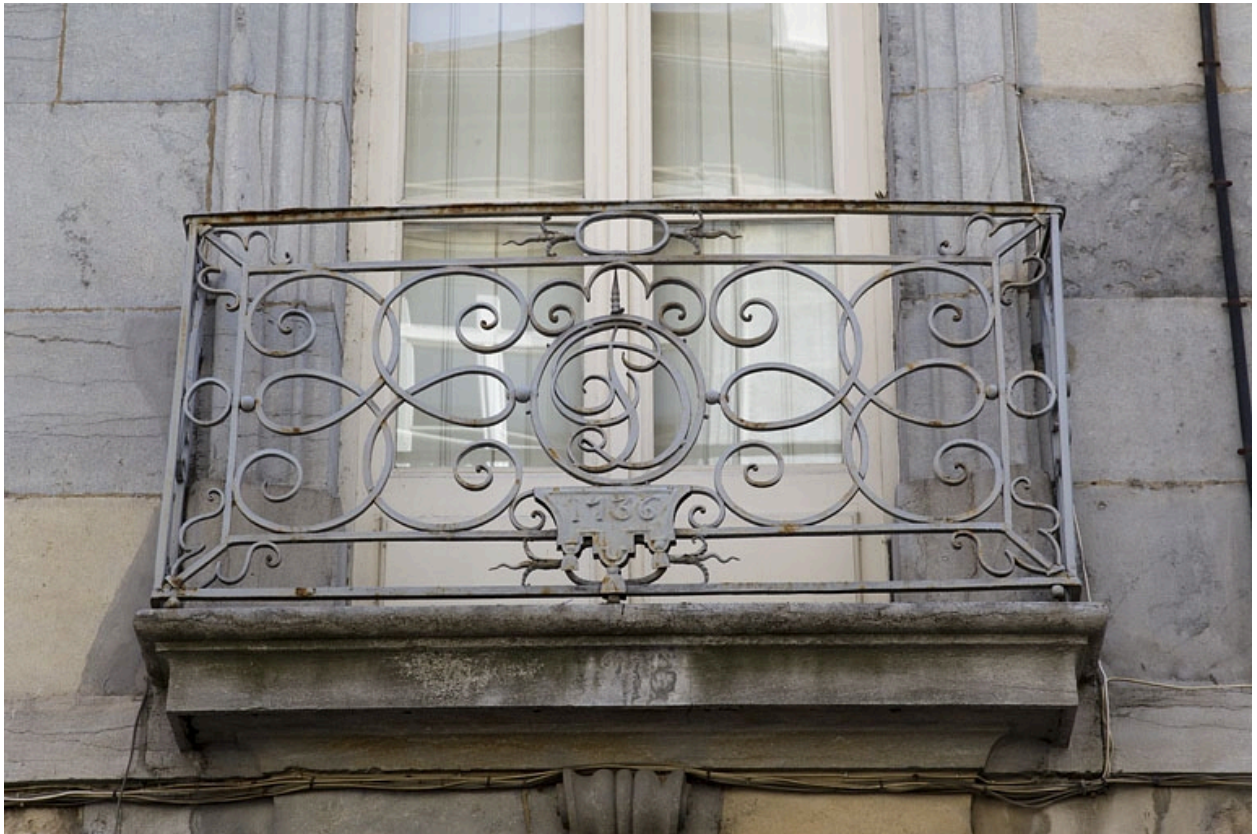
Logis principal, façade antérieure, premier étage : détail du balcon en ferronnerie.
