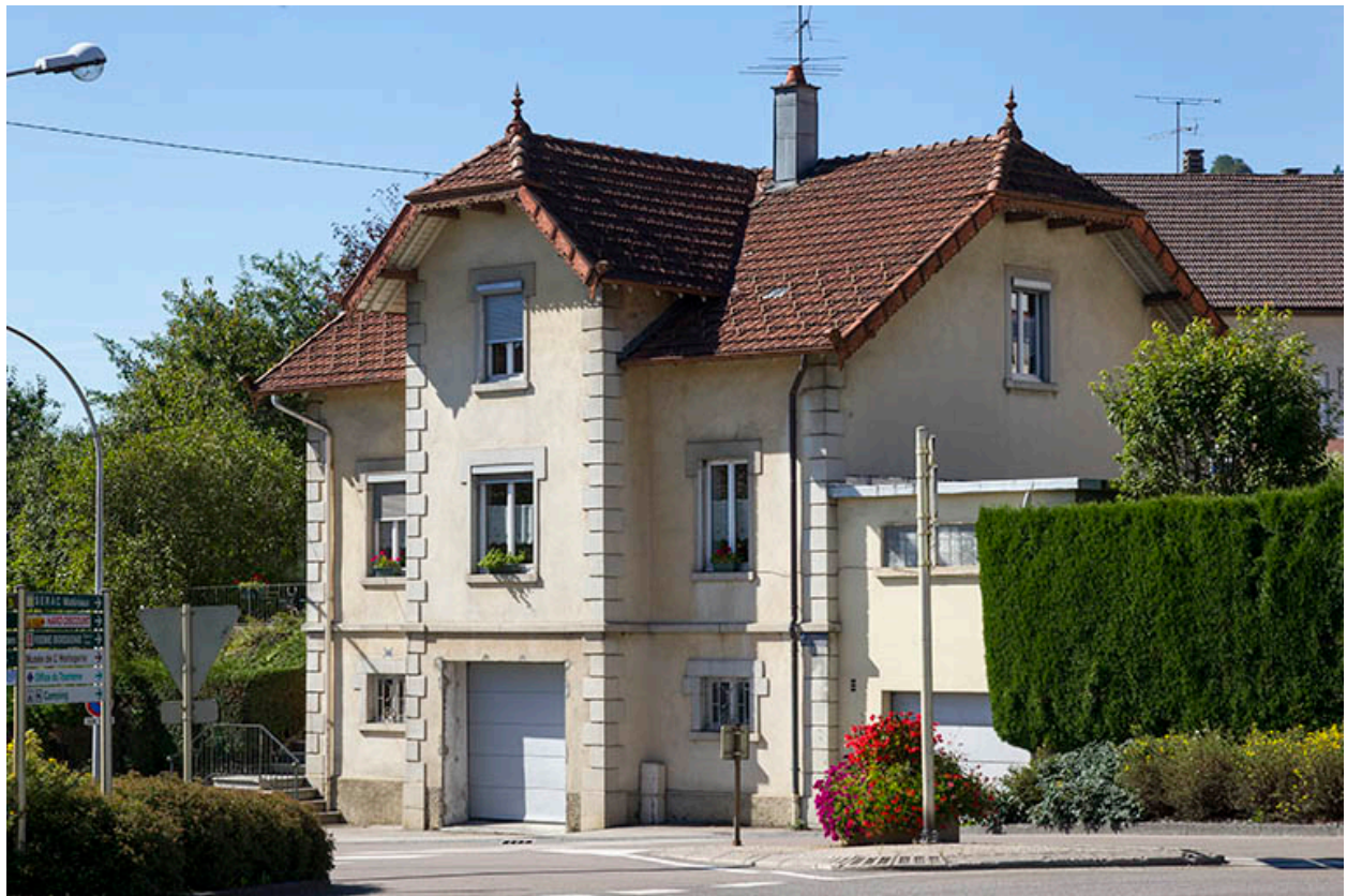
Façades antérieure et latérale droite.
